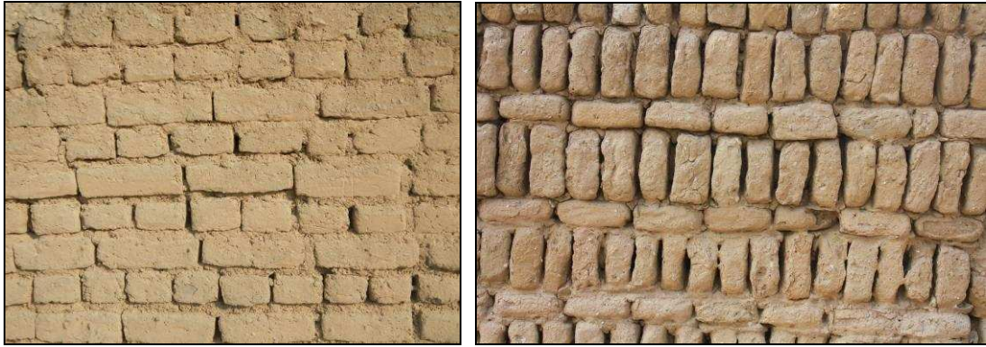
Figura 3. Detalle de aparejos. Izquierda: Muro Ychma – Derecha muro Lima “técnica del librero”.
