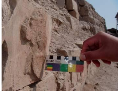
Fig. 5- Detalle de capa de enlucido con pintura mural sobre piedra, después de dos días de haber aplicado la solución de almidón de arroz (crédito: G.Pacheco, 2008)
